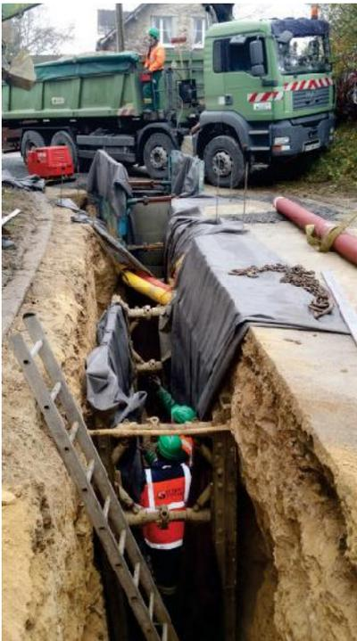
canalisations sont posées au laser, dans un lit de gravier pour assurer leur stabilité et la durabilité de l'ouvrage. La fonte ductile ou le « Poloplaste » sont utilisés en fonction des secteurs selon la profondeur et la pente du réseau. Une boîte de raccordement est installée pour chaque logement à un emplacement défini avec le propriétaire. Une amorce sur laquelle on se raccorde est envoyée jusqu'en domaine privé (il est interdit d'intervenir sur la boîte directement).
