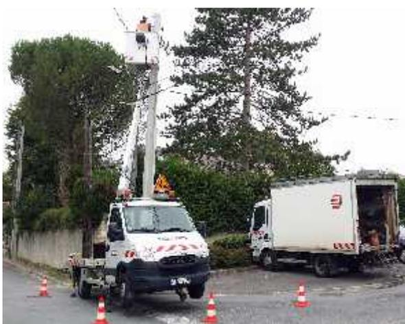
**Mercredi 5 juillet** : début des travaux sur le **RESEAU ELECTRIQUE** avec le remplacement des fils nus par des câbles torsadés ainsi que des poteaux devenus trop faibles.
