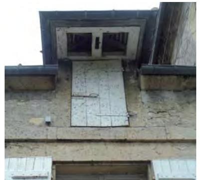
Sur les murs de moellon, appui de fenêtre, harpe et chaînage d'angle en pierre de taille voire brique renforcent la maçonnerie en calcaire.
