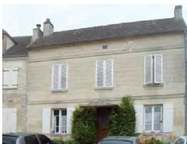
La construction forme un parallépipède rectangle sur deux niveaux, surmonté d'un toit à deux pans entre 35° et 45°, encadré par des souches de cheminée en brique.
