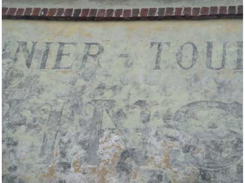
Le moellon calcaire est recouvert d'un enduit qui le protège et apporte de la couleur aux façades. A l'origine, les enduits étaient appliqués totalement (couvrant au mortier de chaux aérienne parfois mélangé avec du plâtre gros, selon le cas) ; ils peuvent représenter des décors : faux pans de bois, dessins de pierre de taille ou autres motifs...
