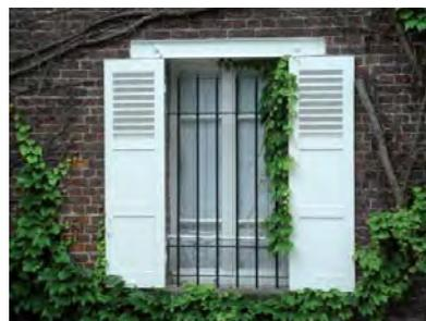
Les volets battants des fenêtres s'encastrent dans les feuillures ménagées à l'extérieur des tableaux.
