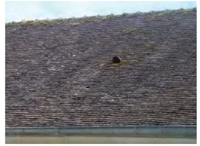
Les couvertures traditionnelles de Courteuil sont en tuile plate de petit moule (60 à 80 au m<sup>2</sup> environ); le faîtage est scellé au mortier clair avec des tuiles demi-rondes (faîtage à crêtes et embarrures).
