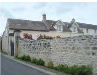
La tuile plate et le moellon calcaire enduit sont les matériaux de construction traditionnels des longères.
