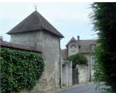
La tuile plate, l'ardoise, le zinc, la pierre calcaire (de taille, en moellon, équarrie, bosselée, layée), l'enduit sont les matériaux de construction traditionnels des villas. Les corniches, bandeaux, encadrements et appuis sont en pierre, en brique, ou recouverts d'enduit.
