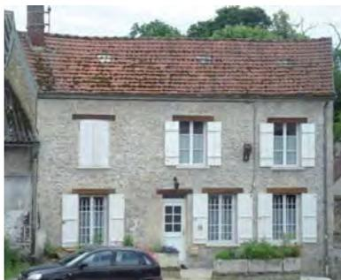
La tuile plate, le moellon calcaire enduit et la pierre de taille sont les matériaux de construction traditionnels des maisons de village.
